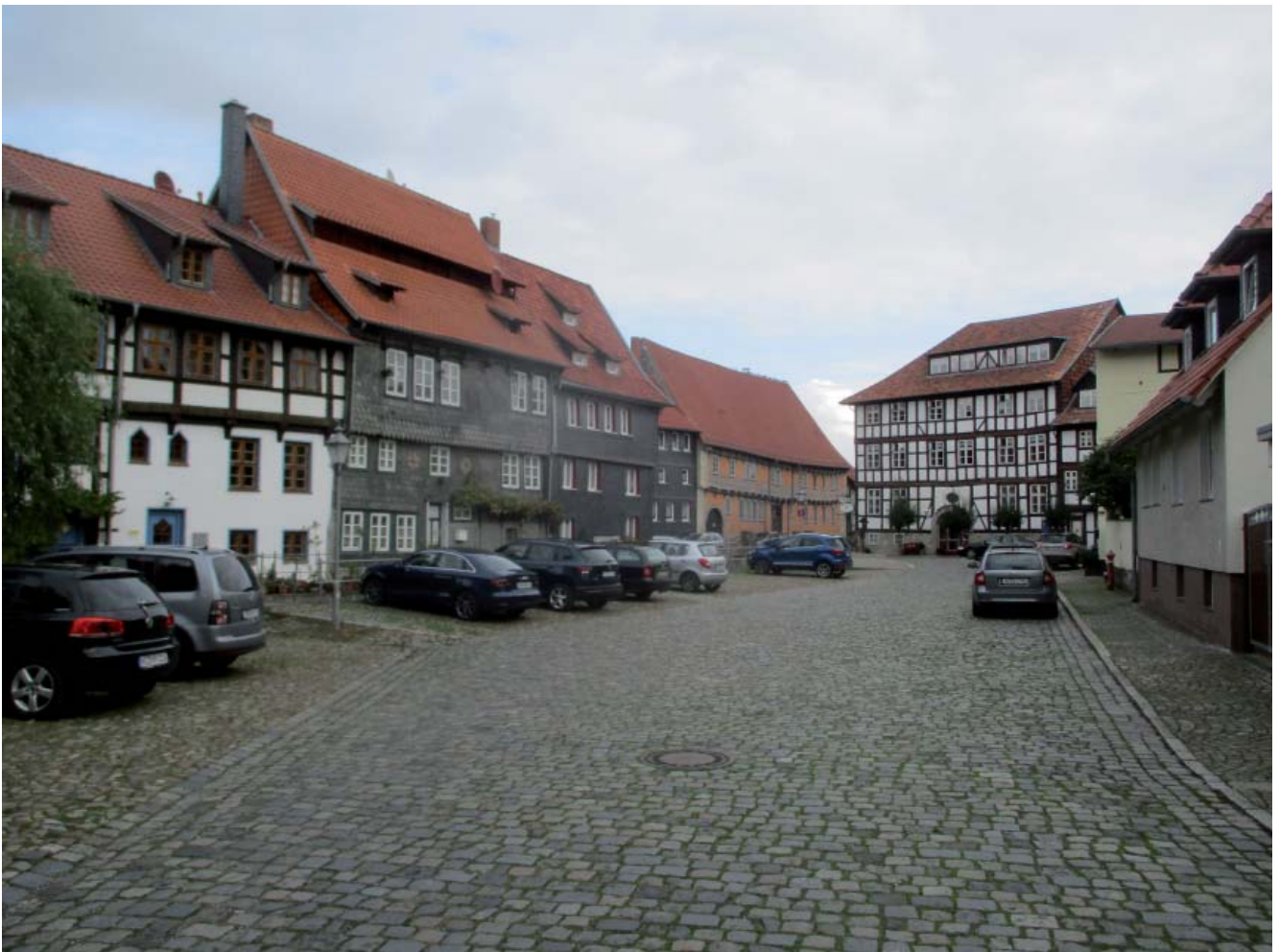
Voigteiplatz nach der Sanierung
